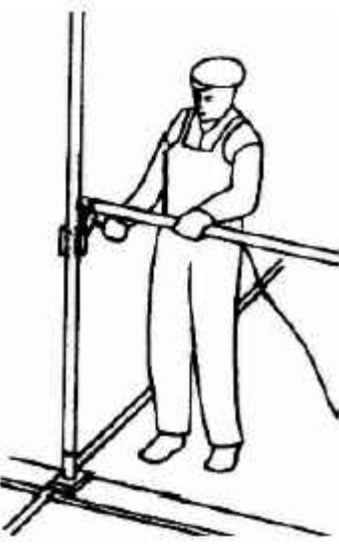
Зняття ригелів першого ярусу і установка їх на третьому ярусі
