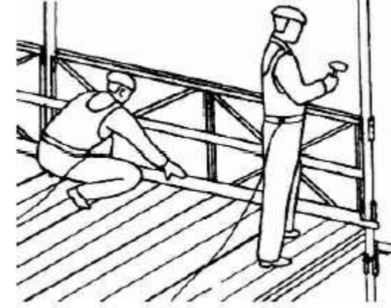
Піднесення та установка елементів огорожі
