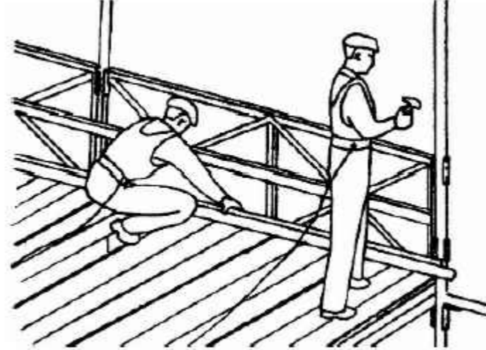
Установка елементів огорожі на третьому ярусі
